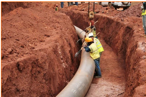
大直径管道安装
